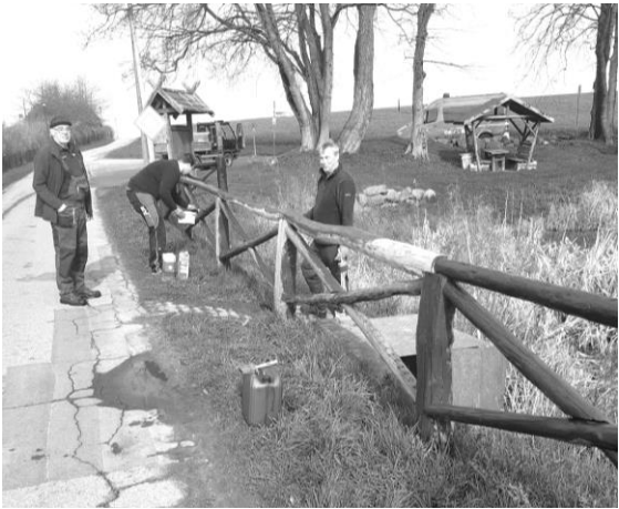
Gemeindearbeiter beim Bau des neuen Geländers in Zarfzow
