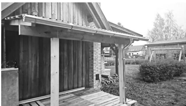
Abb 3: Das Dach mit Trapezblech und Dachrinne ist fertig, das Holz kann kommen
